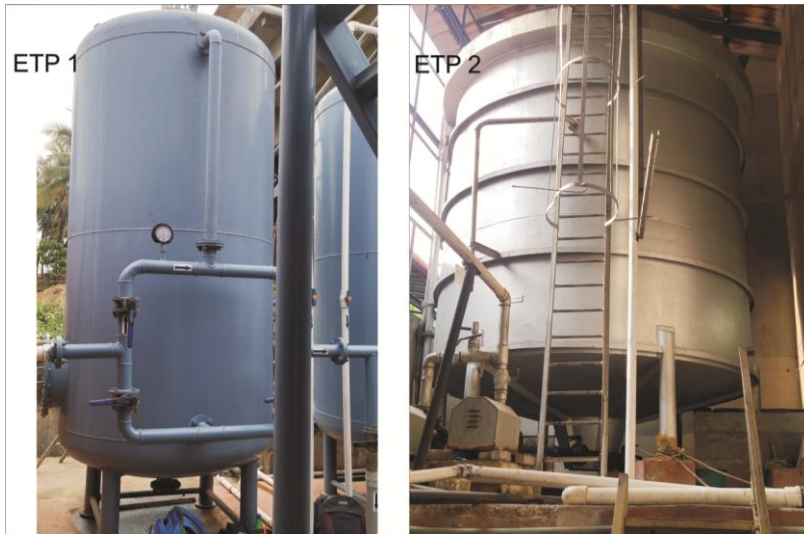
Fig 3: Effluent treatment plants (ETP)
